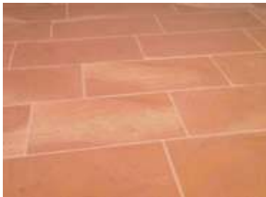
Pose de dalles rectangulaires à joints décalés
